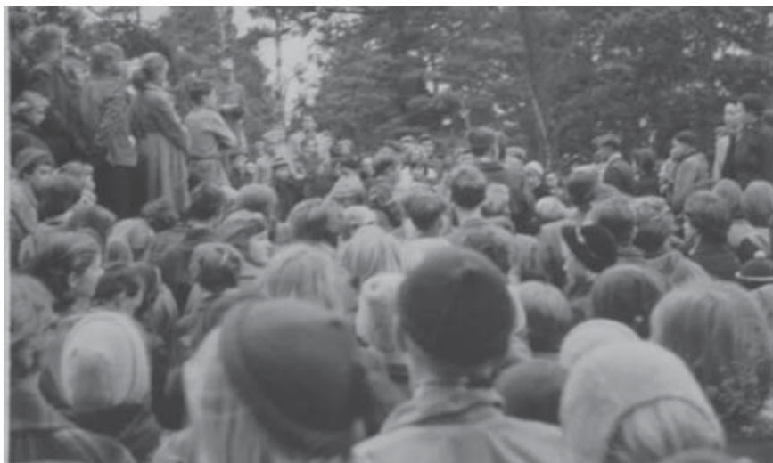
Rektor tar första spadtaget på gymnasielängorna 1951, numera B-längorna.
